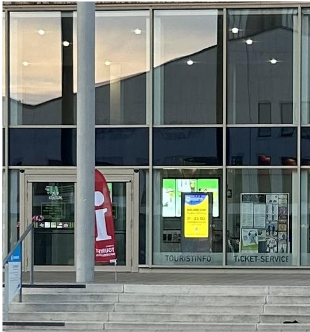
LED-Stelen am Haupteingang
